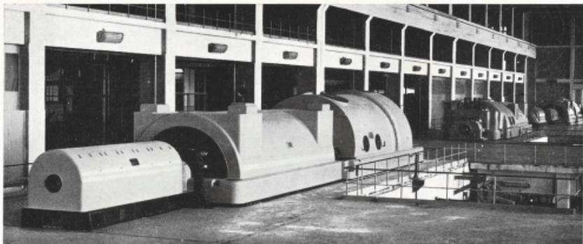
In primo piano il gruppo turboalternatore da 140.000 kW di costruzione "Ansaldo" installato presso la Centrale Termica di Chivasso della SIP - Società Idroelettrica Piemonte. Sullo sfondo altri due gruppi da 70.000 kW ciascuno tutti lubrificati con Mobil D.T.E. Oil
