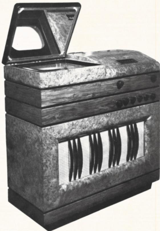
UN modello italiano del 1939: il « fonotelevisore » derivato direttamente dal « radiogrammofono », provvisto di apparecchio radiorecettore autonomo rispetto alla TV: il tubo catodico era collocato verticalmente e l'immagine veniva riflessa sulla superficie speculare nell'interno del coperchio spostabile in varie posizioni.
