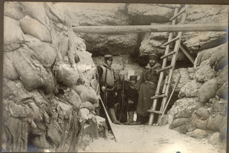
Nel cofano di controscarpa del forte Kikuan Nord, mentre si scavano i pozzi da mine.
