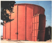
L'edificio metallico, a tenuta, del reattore.
