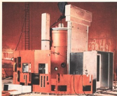
Il reattore Ispra-I in fase di montaggio.
