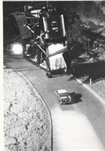
La macchina di ripresa è collegata ad un carrello che le consente di seguire il modellino della vettura. Il risultato apparente di tale operazione è quello di un'automobile autentica in corsa.
