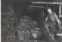
MACCHINE automatiche per l'abbattimento e il trasporto del carbone. I scolari mandati d'avallo possono essere allungati via via che la abbattitrice si addentra nella vena.
