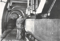
CARICAMENTO automatico del carbone attraverso trasportatori diretti, della taglia ai trasporti meccanizzati.
