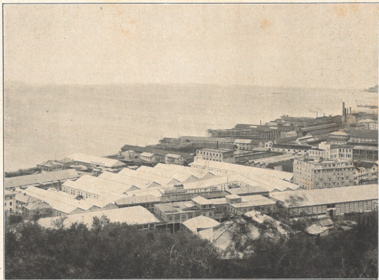
Veduta dall'alto del Cantiere Aeronautico N. 1.
