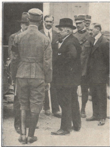
S. E. Chiesa in visita ai cantieri Ansaldo.
