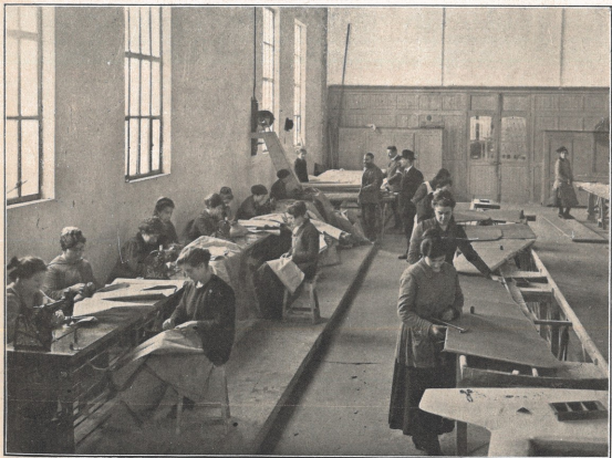
Cantiere Aeronautico N. 1.
