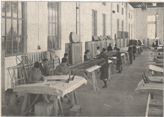
Cantiere Aeronautico N. 1.
