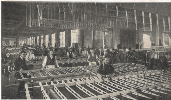
Cantiere Aeronautico N. 5.
