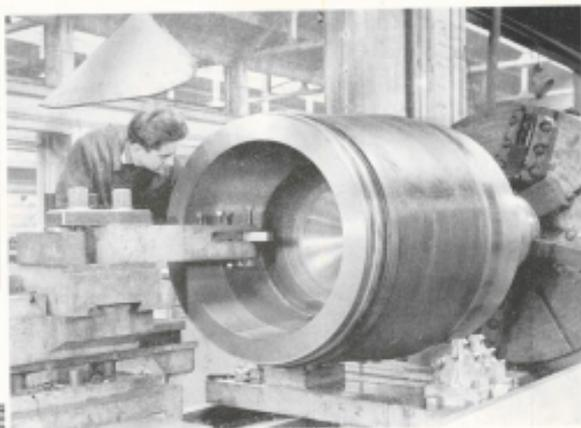
Operazione di tornitura della parte cava di un sembroter, lato ammissioni. Il rotore verrà montato su una delle due turbine da 8.500 kW ordinate all'Ansaldo dalla Società «Agip-Nucleare», e costruite al CMI. La fotografia mostra, al lavoro, il tornitore Sergio Moneghelli.
