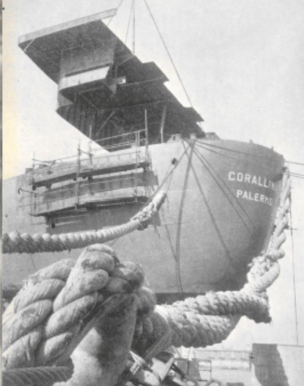
Costruzione 1563 (motonave da 15.290 t.d.w.): imbarco di un blocco delle sovrastrutture poppiere
