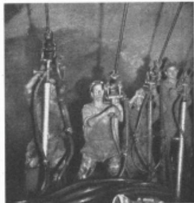
Perforazione con macchine singole ad aria compressa.
