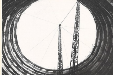
IL MONTAGGIO dell'edificio del reattore nel centro atomico che sorge a Ispra.
