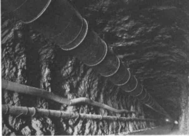
La condotta di ventilazione per il cantiere interno nel traforo del Monte Bianco
