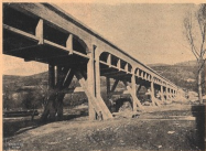
Ponte a sifone sulla Grotta di Venosa.
