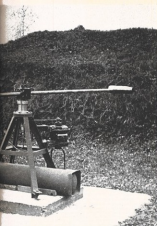
BANCO di prova Partel per stazionatori da applicare alle estensioni delle pale di un elicottero. Sotto l'antenna.
