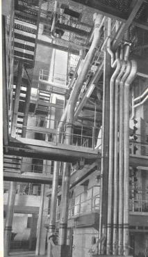
Le tubazioni del carbone che porta, a sinistra, la cassa del forno a cotta dolce
