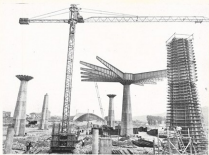
L'ORIGINALE COSTRUZIONE A PUNDI DEL PALAZZO DEL LAVORO. SI SOGGIANO LE MURIE DEI PILASTRI, CINGHIO DEI QUALI SORREGGONO CON UNA STRUTTURA NEOLATINA IN EQUILIBRIO DEL SOFFITTO.
