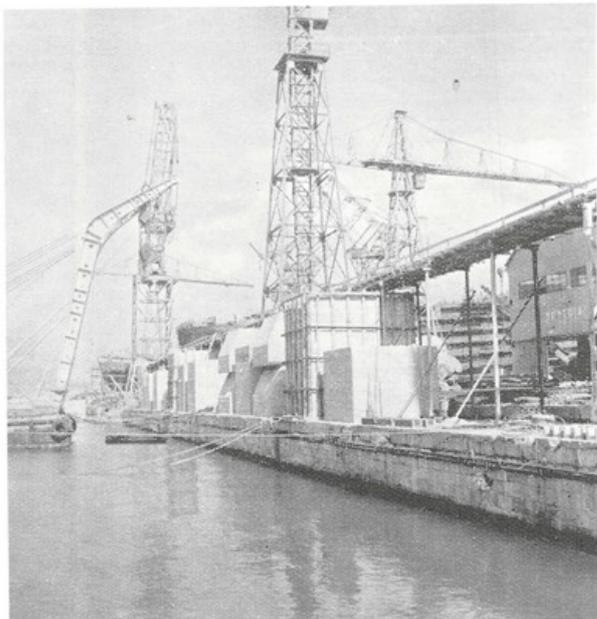
Proseguono al Cantiere di Muggiano i lavori per il prolungamento del molo « Mahroussa ». Si tratta di un'opera che consentirà, a lavori ultimati, di disporre di una banchina della lunghezza totale di metri 277,50, lungo la quale potranno essere attraccate, durante la fase di allestimento, due navi di grande tonnellaggio.
