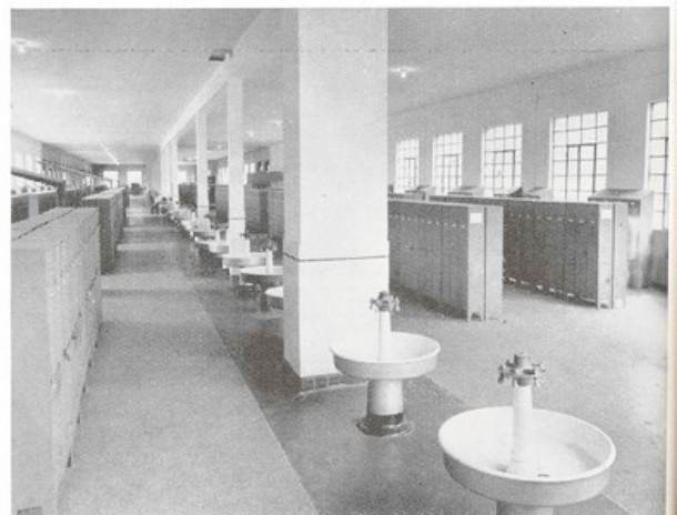
Gli spogliatoi degli operai sono stati recentemente riordinati e rimodernati. Gli armadietti sono stati riparati o sostituiti, gli impianti igienici resi più razionali e i locali e mobili riverniciati
