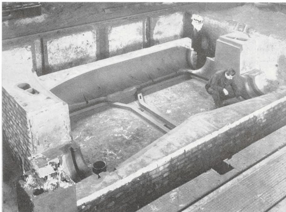
Formatura della testata anteriore di ghisa per il condensatore principale della turbonave passeggeri «Leonardo da Vinci», in costruzione al Cantiere di Sestri per la Società «Italia»
