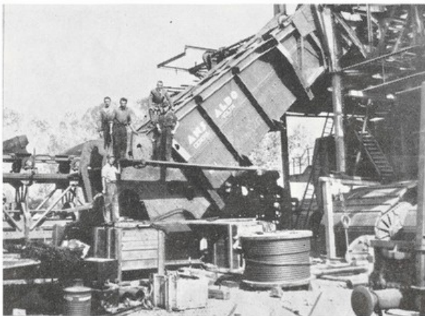
La Sezione di Voltri dello stabilimento C.M.I. ha costruito, per conto della Società «Krupp» di Essen, i canali per una scavatrice dragante destinata alle miniere di S. Barbara di Castelnuovo dei Sabbioni. Dall'alto: assieme del trave scavatore con le tazze scavatrici; fase di assiemamento e vibratura dei canali
