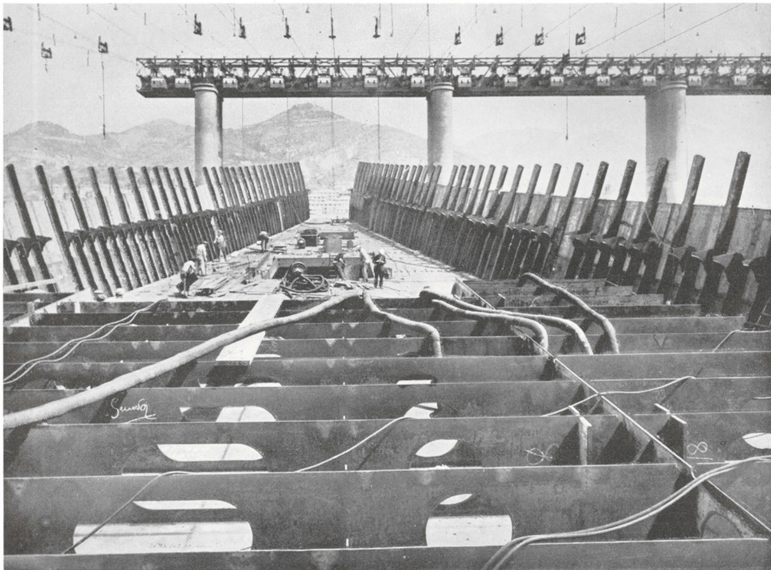
Sopra: una veduta, verso prora, dello scafo della turbonave passeggeri «Leonardo da Vinci» in costruzione al nostro Cantiere di Sestri. - Sotto: due aspetti della prefabbricazione di strutture della turbocisterna «Felce» di 31.500 t.d.w. in costruzione al nostro Cantiere navale di Livorno per la Società «Nereide» di Palermo.
