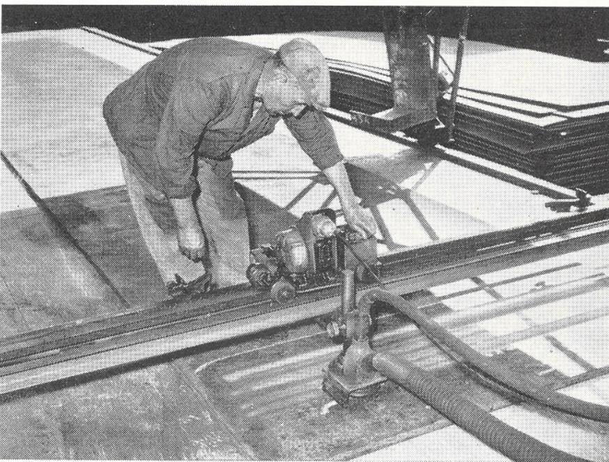
Sopra: carrello e campana sabbiante in funzione sulla superficie di una lamiera da « decalaminizzare ». Alla macchina l'operaio Alloisio. Sotto: veduta di una campata del parco profilati
