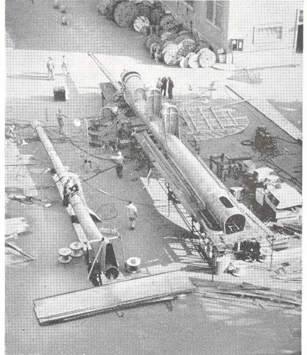
L'albero di trinchetto e quello di maestra della «Gripsholm» in costruzione sulla banchina dell'Allestimento
