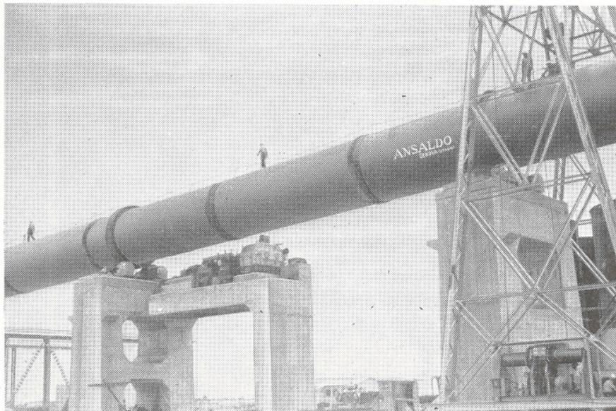
La grande cementeria costruita dal nostro stabilimento CMI per la Società venezuelana «Cementos Coro» è attualmente in fase di montaggio a Chichiriviche. La fotografia mostra la sistemazione di un forno rotante lungo m. 106,75 e del diametro di m. 3,355
