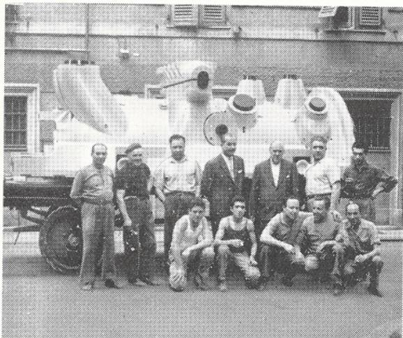
Modello della parte inferiore di una cassa turbina di alta pressione facente parte delle macchine e delle attrezzature che il Meccanico fornirà per le centrali termoelettriche da 140.000 kW della « Società Termoelettrica Tirrena » a Civitavecchia e della « Società Idroelettrica Piemonte » a Chivasso. Il pezzo, fuso alla « S.I.A.C. » in acciaio speciale, pesa 8700 Kg.
