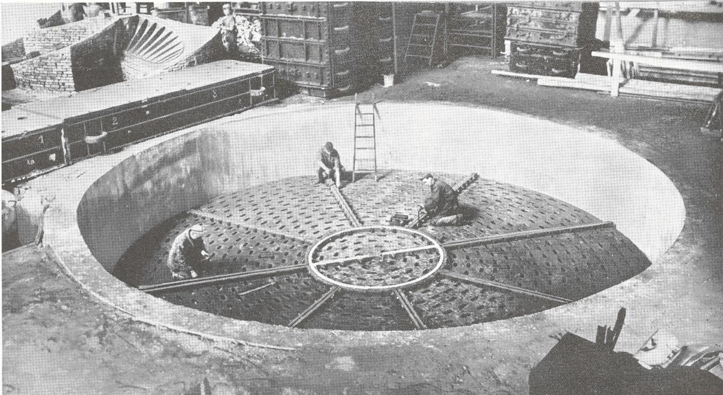
Costruzione di una nuova « piazza », del diametro di m. 10 e della profondità di m. 1,50, per la fusione delle grandi eliche
