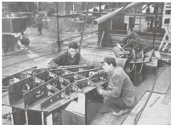
Prefabbricazione del braccio port'elica destro di una delle corvette indonesiane. Da sinistra: il tracciatore Galeno Folena, il tracciatore Vinicio Lubrano e l'ossigenista Ottorino Bocci
