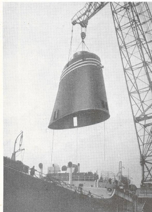
Una fase dell'allestimento della T/c « Miraflores » di 31.500 T.D.W., ormai pronta per le prove ufficiali, al Cantiere di Sestri: l'imbarco del fumaio saldato e prefabbricato a terra.
