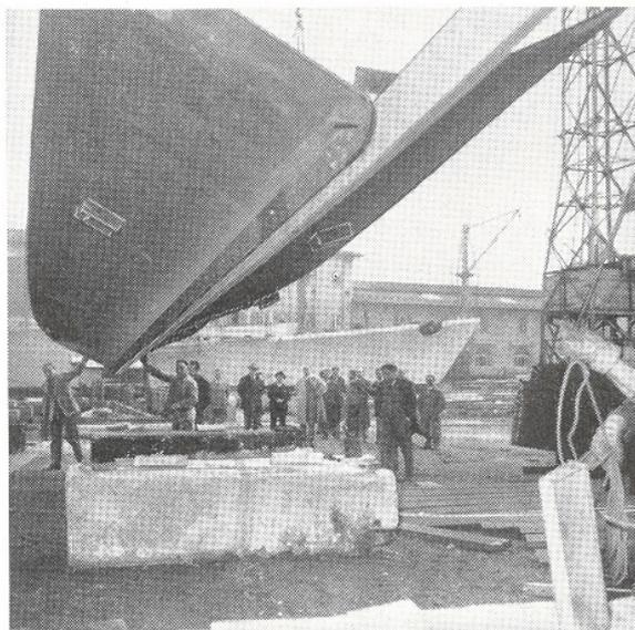
Il 3 dicembre scorso al Cantiere di Livorno è stato impostato il rimorchiatore d'alto mare « Giuseppe Orlando » della Ditta « Fratelli Neri » di Livorno. Il rimorchiatore, a scafo d'acciaio e ad un'elica, avrà una lunghezza di m. 28,21, un apparato motore di 750 C.A. e una velocità di 12 nodi.
