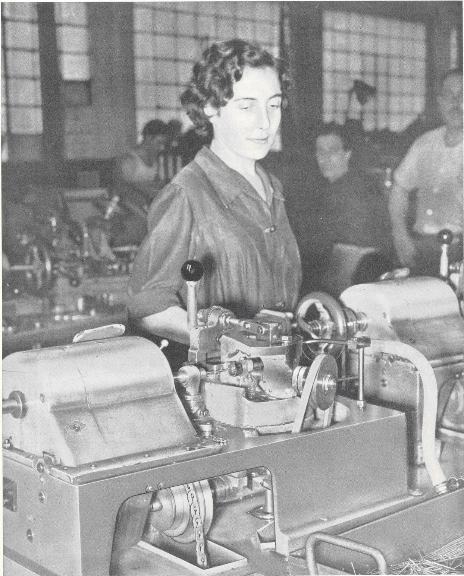
L'operaia Franca Balsamo della Sezione Utensileria del Ferroviario mentre lavora ad una scanalatrice per punte Ambrosi.
