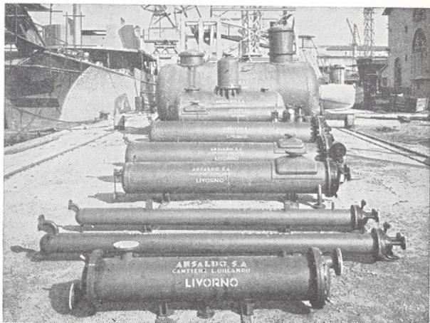
Per la Centrale termoelettrica da 3000 kW, della Società Elettrica dell'Elba (S.E.D.E.) il Cantiere di Livorno ha costruito un evaporatore, due condensatori, cinque riscaldatori, un degasatore e un raffreddatore.
