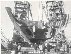
In alto a sinistra e sopra: due momenti dell'imbarco della poppa prefabbricata di una turbocisterna da 52.500 t.d.w. ordinata al Cantiere di Sestri dalla Società di navigazione «Egria» di Palermo - Sotto: guida pattino in ghisa, del peso di 3.000 kg., tesa alla nostra Fonderia
