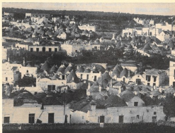
I tetti di Alberello.
