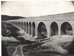
Ponte Canale di Atella
